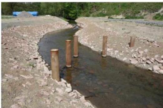
Abbildung 8: V-Rechen im Bereich des Hochwasserrückhaltebeckens Wippra (Eiden 2016).
