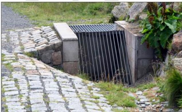
Abbildung 5: Das Foto zeigt ein leistungsfähiges Einlaufbauwerk ohne Schlamm- und Geröllfang (Halbach, 2011).
