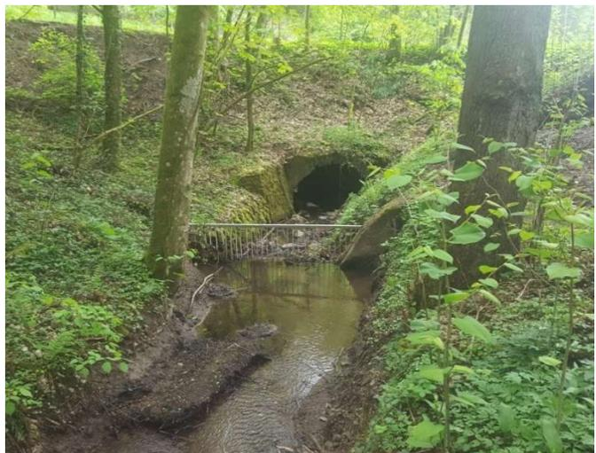
*Bild 3: Auslass der Verrohrung –
