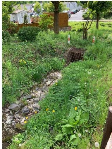
*Bild 48: Auslass Verrohrung Arzbachstraße – Eisenbach*
