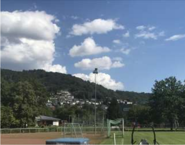
Flutlichtanlage des Naturrasenplatzes am Sportzentrum Nassau vor der Sanierung
