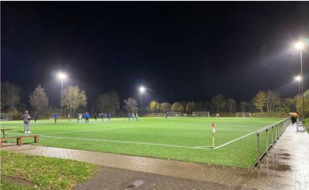
Abbildung: Flutlichtanlage des Kunstrasenplatzes am Sportzentrum Nassau nach der Sanierung
