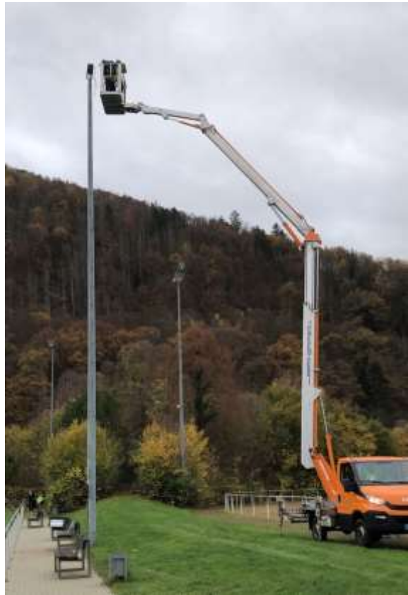
Abbildung: Flutlichtanlage des Kunstrasenplatzes am Sportzentrum Nassau vor der Sanierung
