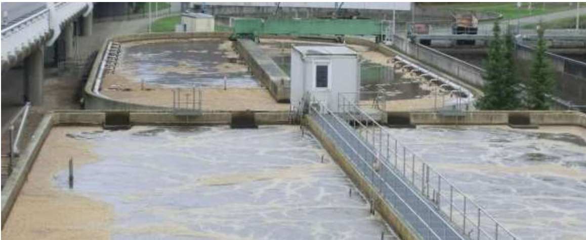
Abb. Klärwerk Bad Ems
