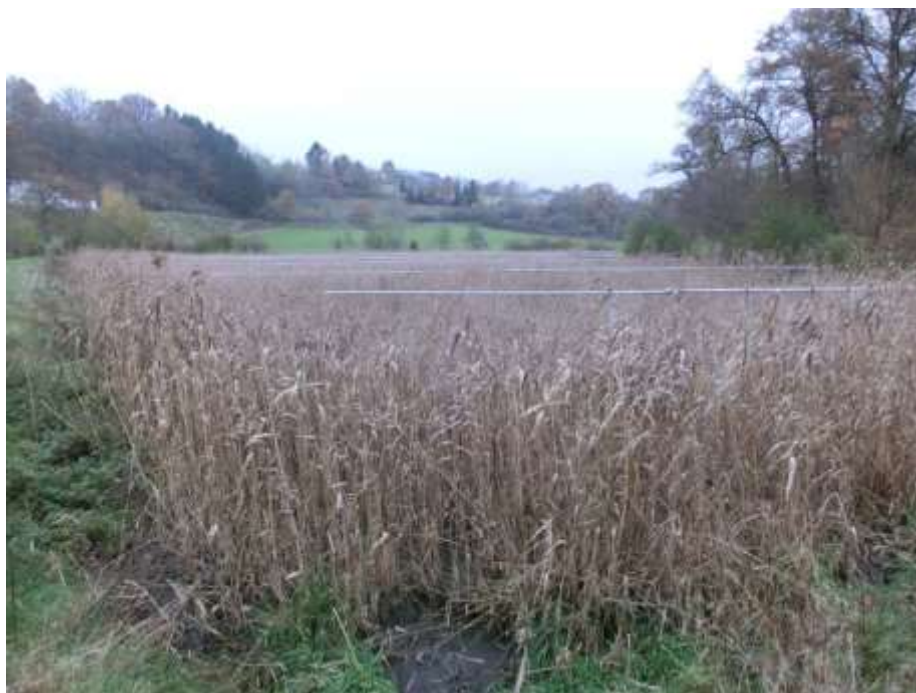
Abbildung 4-28 Vererdungsanlage KA Dörsbachtal
