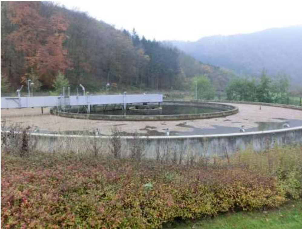
Abbildung 4-27 Belebungs- und Nachklärbecken KA Nassau
