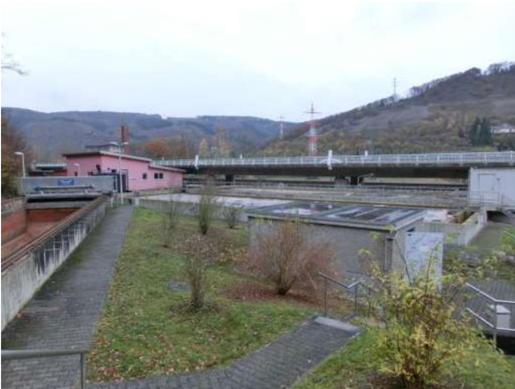
Abbildung 4-29 Belebungsbecken und Verwaltungsgebäude KA Bad Ems
