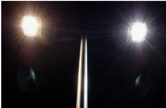
Abbildung 4-20: LED Straßenlampe warmweiß-kaltweiß
