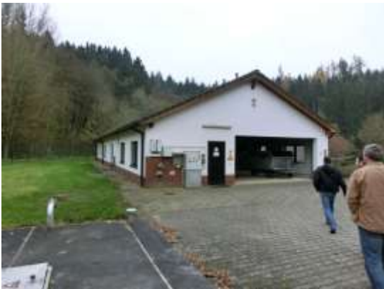
Abb.: Betriebsgebäude der Kläranlage Dörsbachtal
