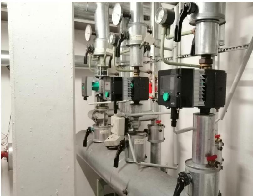
Abbildung 3: neue Umwälzpumpen der Heizungsanlage am Feuerwehrgerätehaus in Nassau
